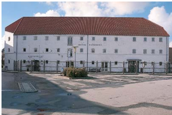
Toldbodgade 12, Nykøbing. Pakhuset har tilhørt flere af byens købmænd. Det er opført 1850. Den meget markante teglstensbygning er i dag hvidkalket. Facadernes åbninger er alle afsluttet med et fladbuet stik. Facaden mod havnen havde oprindeligt to rækker hejseluger med lemme.
