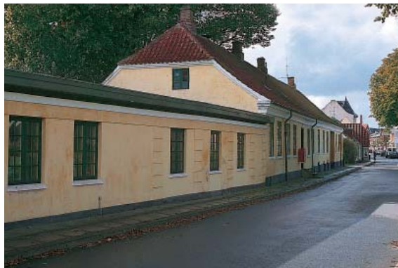
Østergade 36, Nykøbing. Det meget enkle og velbevarede længehus er opført i 1854. Den murede bygning fremstår mod Østergade gulkalket og med hvidkalkede detaljer og grå sokkel. Bygningen har port. Åbningerne i murværket er øverst afsluttet med et lige stik. Sålbenkene er murede. Den hvidkalkede gesims er en tandsnitsgesims med trappefremspring. Bygningens fire skorstene har sokkel, pibe og gesims. Bygningens bagside står i blank mur i gule teglsten, som er produceret på Resengaard Teglværk.
