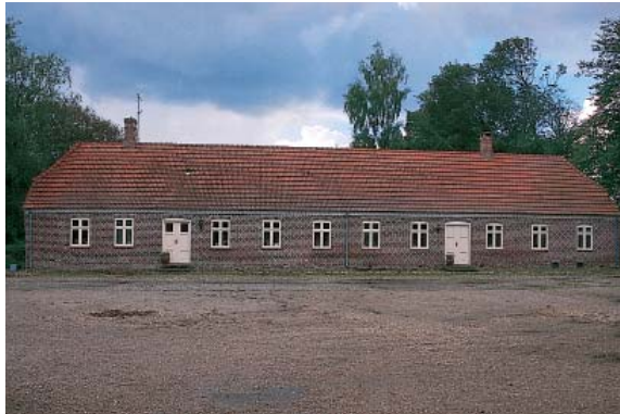
Lødderupvang 8, Lødderup. Stuehus opført i 1827. Bygningen er bygget af røde teglsten. Facaderne er præget af tidstypisk byggeskik som bl.a. halvstens fladbuet stik over dør- og vinduesåbninger, murværk muret i krydsforbandt og facaden, der øverst er afsluttet med et kopskifte før den hvidkalkede tandsnitsgesims. Skorstenene er muret med sokkel, pibe og gesims.
