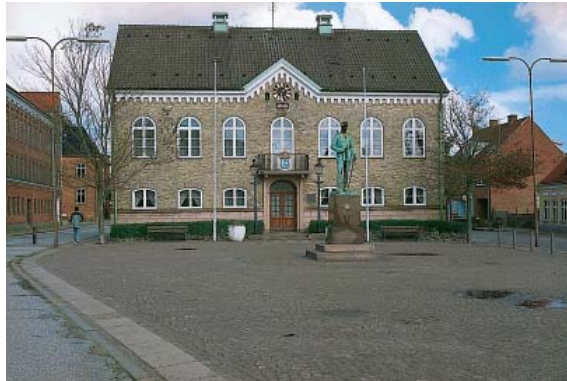
Rådhusstorvet, Nykøbing. Rådhuset er opført 1846. Bygningen er tegnet af arkitekt J.P. Jacobsen og restaureret af kgl. bygningsinspektør E. Packness i 1934. Den smukke bygning er muret i krydsforbandt og har en sandstensbeklædt sokkel. De murede stik over vinduerne er enstens stik. En trekantfronton med ur markerer bygningens midterakse samt tillige hovedadgangen og balkonen. Gesimsen er meget karakteristisk og udført med elementer inspireret fra draperier.
