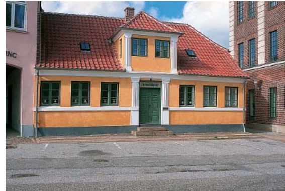
Rådhusstorvet 2, Nykøbing. Bygningen var tidligere kontorbygning for Morsø Jernstøberi og er opført omkring 1847. Den pudsede og kalkede bygning har flere tidstypiske detaljer, som for eksempel den murede kvist, der markerer indgangspartiet, de kannelerede pilastre på begge sider af indgangspartiet og på kvisten. Båndet under vinduerne og den trukne gesims giver facaden vandrette linjer. Taget på bygning og kvist har halvvalm. Facadens gule grundfarve og detaljernes hvide farve er tidstypisk.
