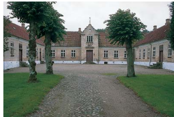
Ullerupmark 21, Ullerup. Herregården Ullerup. Hovedbygningen består af tre fløje, er opført i 1863 i gule teglsten i krydsforbandt, soklen er hvid. Hovedfløjen har en frontispice, der markerer hovedindgangen og anlæggets symmetriakse. Frontispicen har murede pilastre med kapitæl, der ubrudt spænder fra sokkel til gesimshøjde. Øverst er et felt med løgkuppelmotiv. Afslutningen er inspireret af renæssancens formsprog og er et udtryk for den frie historicisme, der afløste senklassicismen. Over døren er muret et felt til initialer og årstal.
