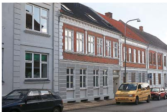
Jernbanegade 5, Nykøbing. Bygningen er opført i 1899. Industrialismen medførte indvandring fra land til by. Staten påbegyndte jernbanen på Mors, og der kom statsbanefærgen til Glyngøre. En ny bygningstype opstod med udlejningslejligheder. Det er muredetaljernes rigdom, der præger den historicistiske facade. En naturstensefterligning i stueetagen ved refangfugning. Førstesalen har efterligning af natursten i kvaderstenslisenerne. Under vinduerne er et fornemt mønstermurværk. På den gennemgående sålbænk er anbragt to kannelerede lisener med kapitæl og base, som bærer en markant tandsnitsgesims.
